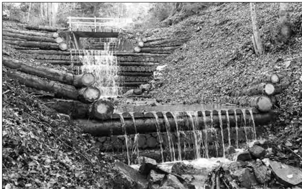
Vue des deux ouvrages réalisés cet automne en-dessous du pont des Méley
