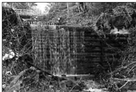
Ancien barrage en bois et pierres situé dans le même secteur et encore en bon état
