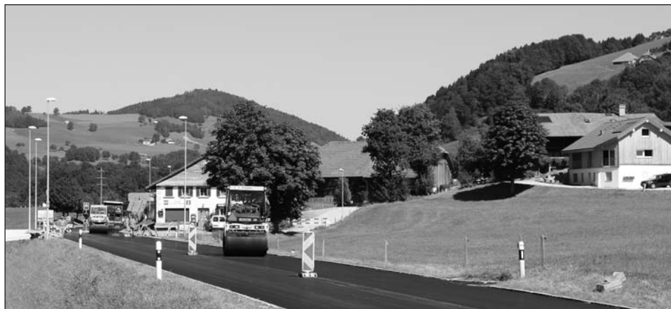
Pose d'un bitume «phono-absorbant» sur la route cantonale (8 septembre 2016)
