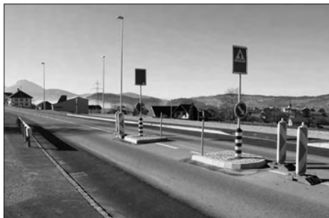
Ilot central avec passage à piétons
