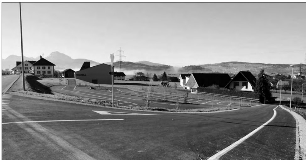
La route d'accès au parking du complexe communal a été élargie. Un cheminement pédestre depuis la Croix-Blanche assure la sécurité des piétons.
